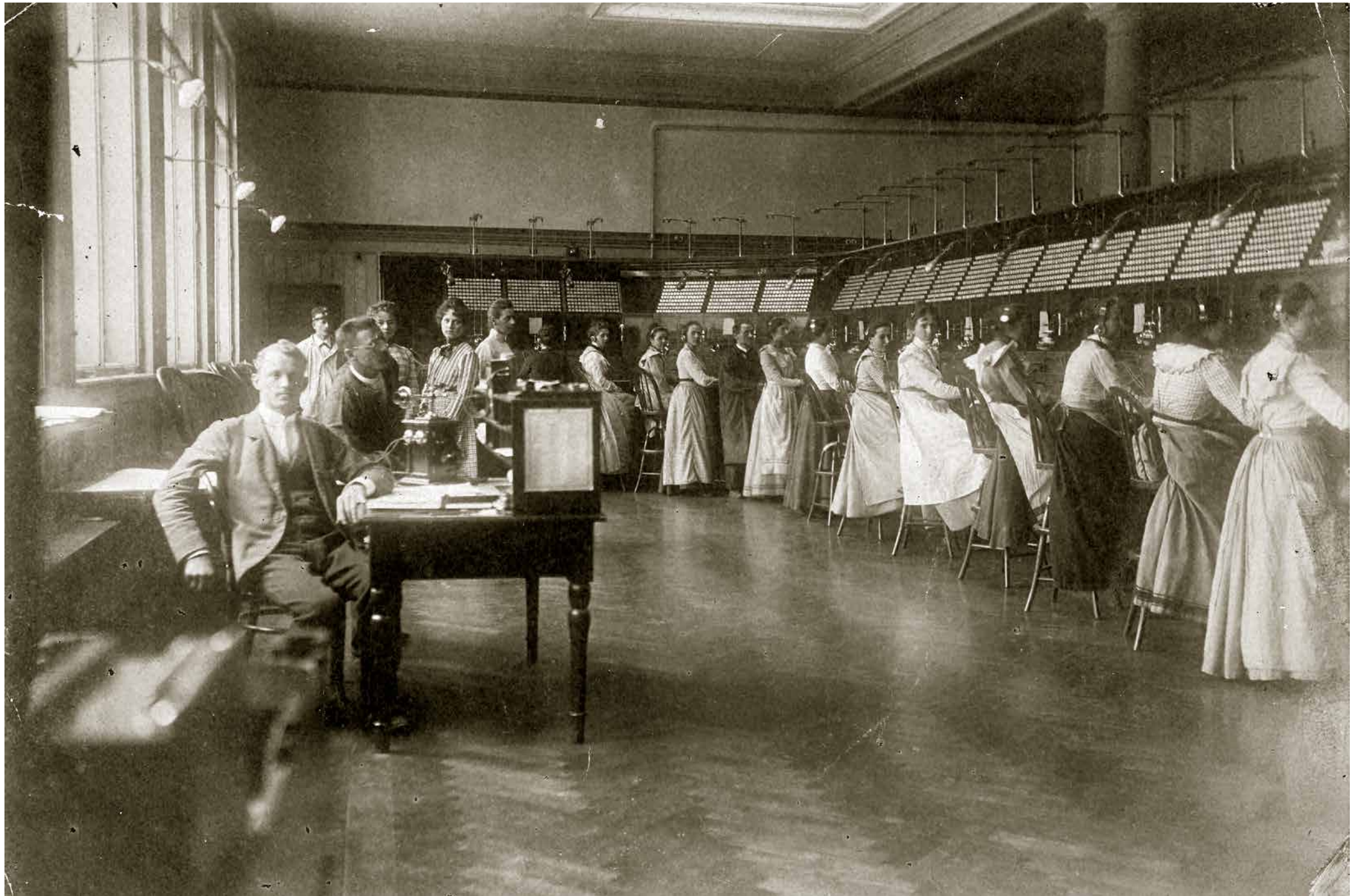
Telefonzentrale Bern, Lokalbatterie um 1896. (Bild: Museum für Kommunikation, Bern)
