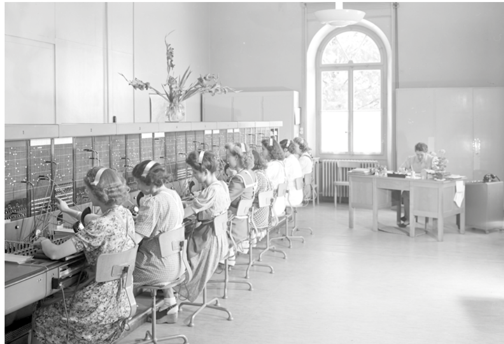
Oben: Ausrüstung der automatischen Telefonzentrale Bern-Bollwerk I, 1926. Unten: Telefonzentrale im Bundeshaus in Bern, 1947. (Bilder Museum für Kommunikation, Bern)
